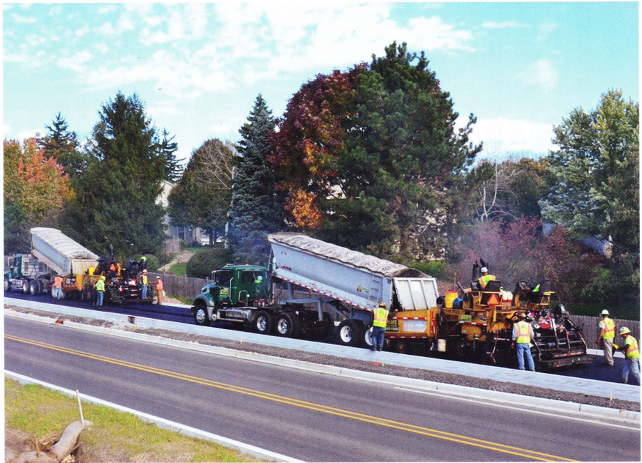
Relixer wird seit über sechs Jahren in Nordamerika und über drei Jahren in Asien kommerziell für Asphaltmischgut mit hohem Recyclinganteil verwendet. (Quelle: Sripath)
